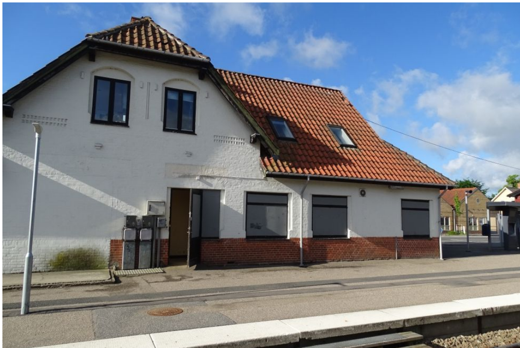
Stationsbygningen i Stenlille har ligget ubrugt i flere år
